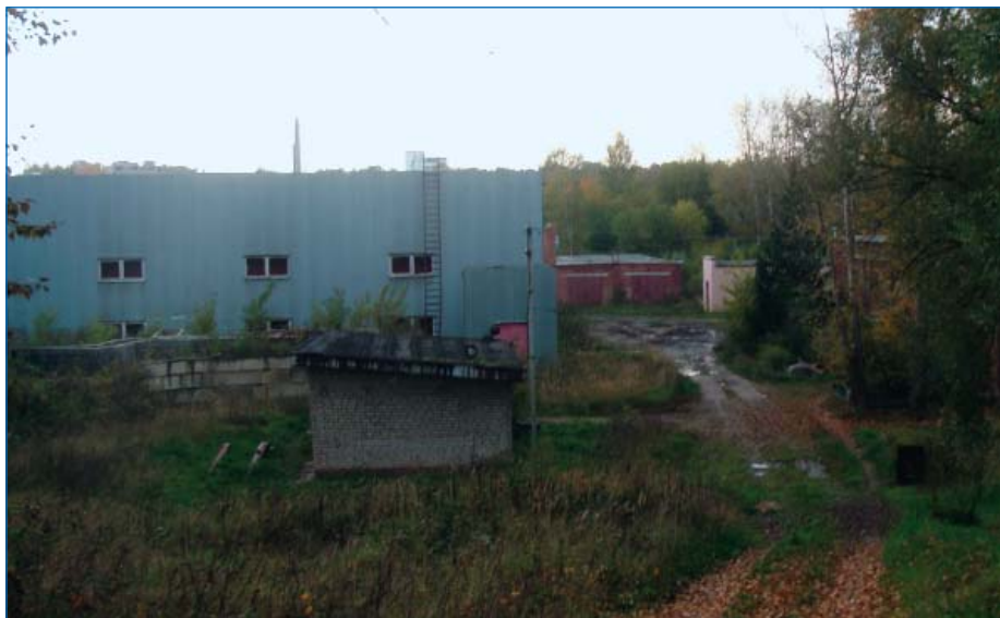
■ Рис. 1. Очистные сооружения ОСК-1
